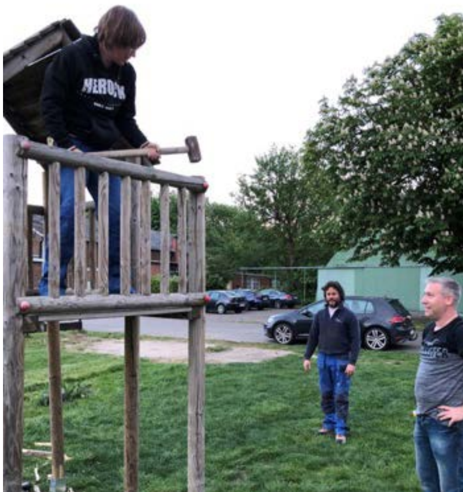
Griet, Jörgen en Bart bij het installeren van de speeltuin
